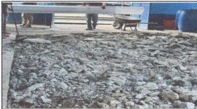
Foto 7: trabajo de demolición de plancha de concreto de patio.
