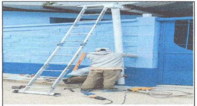
Foto 4 Trabajo de Reparación de bajada de agua Pluvial tubo Pvc 3
