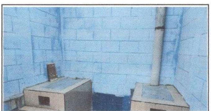
Foto 12: Instalación de dos chimenas de concreto sustituyendo la de metal
