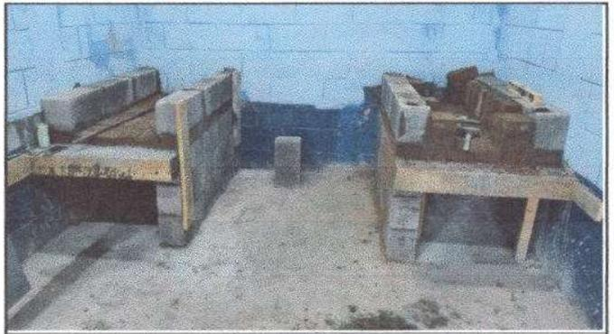
Foto 8: Trabajo de sustitución de Estufa Rural y creación de otra estufa (Incluye chimenea y Plancha de Metal y con forro azulejado.
