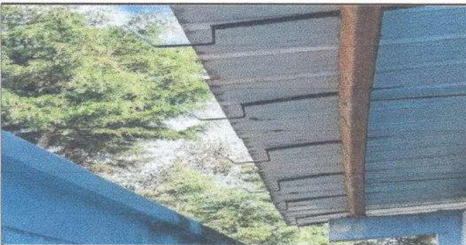
Foto 5: Realización de Sustitución de Soporte o Pesacante de Metal para canal tanto parte interior y exterior
