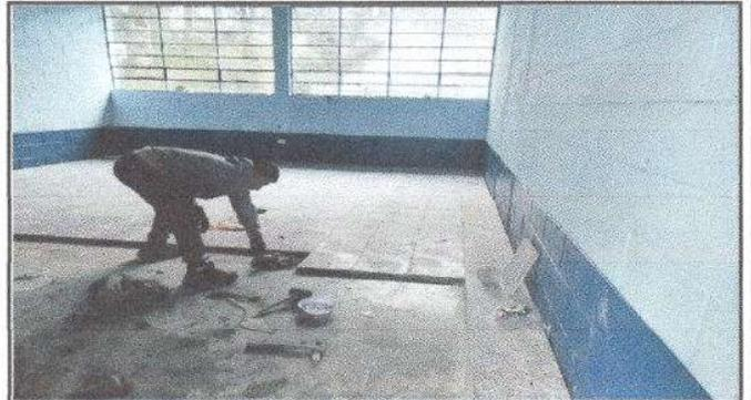
Foto 2: Proceso del cambio de piso de Granito
